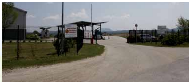
Obstoječi vhod na CER0 II Pragersko
