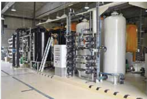
Notranjost čistilne naprave
