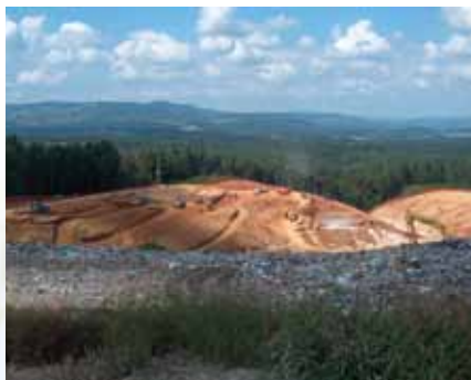
V času gradnje
