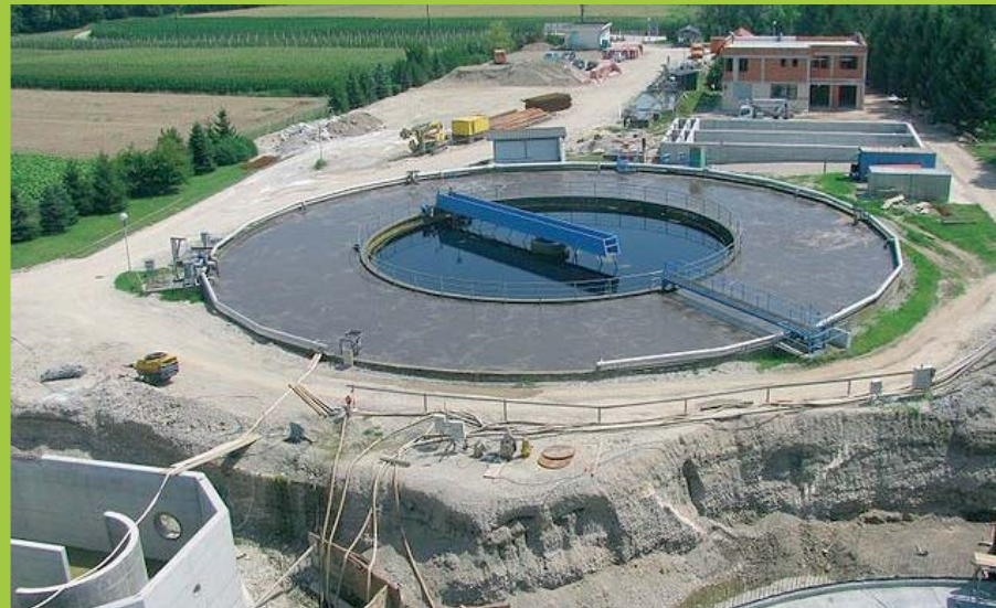
Izgradnja čistilne naprave Kasaze
