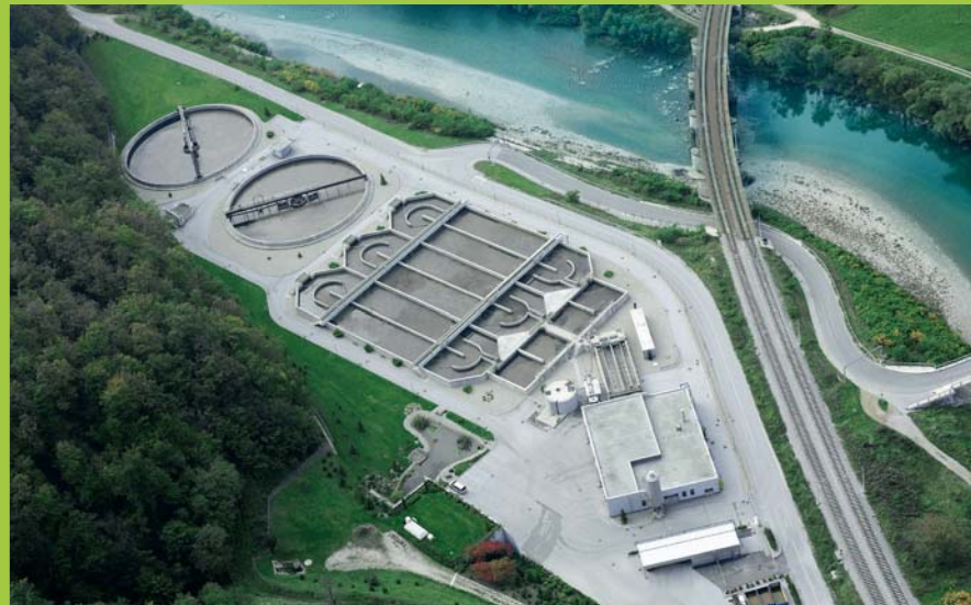
Čistilna naprava Celje
