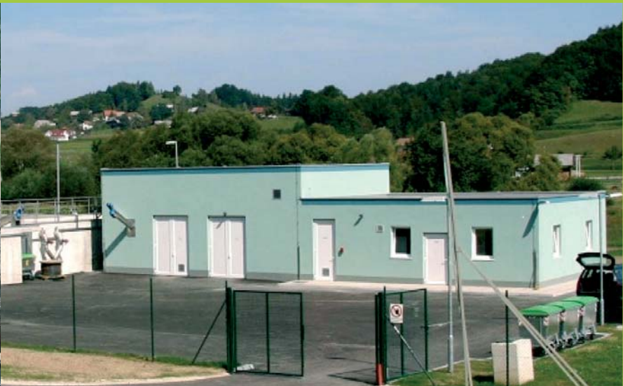
Čistilna naprava Šentjur
