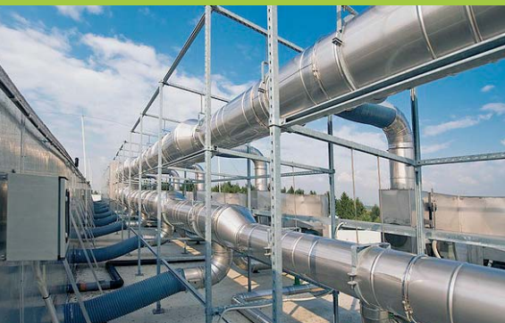
Prezračevalni sistem v kompostarni
