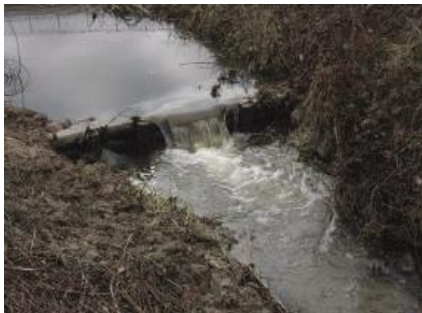
Slika 58: Odbijač in prag na revitaliziranem Peskovskem potoku (Vir: Arhiv LIMNOS).
