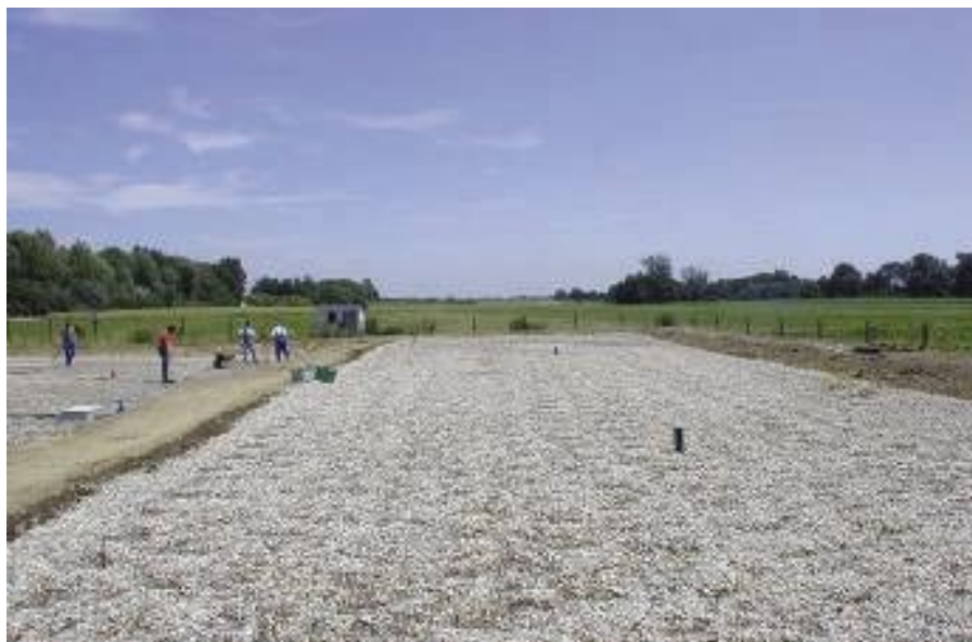
Slika 47: Izgradnja rastlinske čistilne naprave za čiščenje odpadne vode iz živilsko-predelovalne industrije v Središču ob Dravi (Vir: Arhiv LIMNOS)
