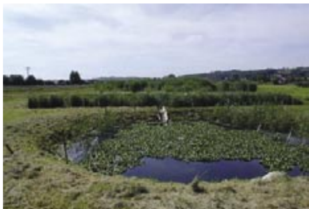
Slika 45: Rastlinska čistilna naprava za čiščenje komunalnih odpadnih voda iz naselja Velika Nedelja (Vir: Arhiv LIMNOS)
