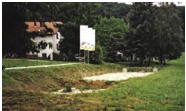
Slika 55: RČN za čiščenje odpadnih voda iz predelave rib in komunalne odpadne vode (Vir: Arhiv LIMNOS)
