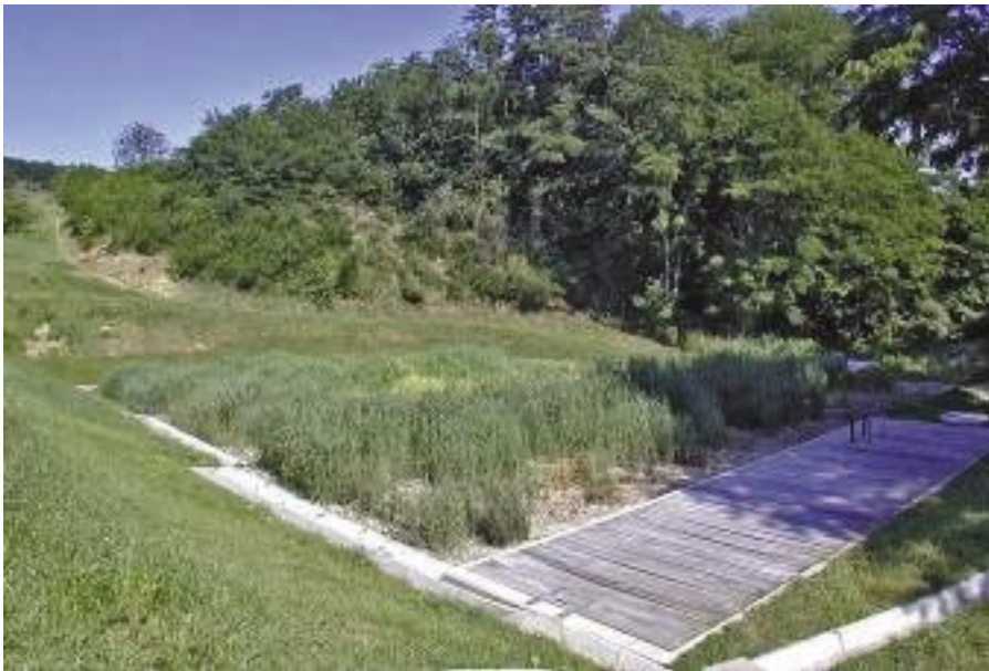
Slika 51: Rastlinska čistilna naprava za čiščenje izcednih voda iz deponije Ljutomer (Vir: Arhiv LIMNOS)
