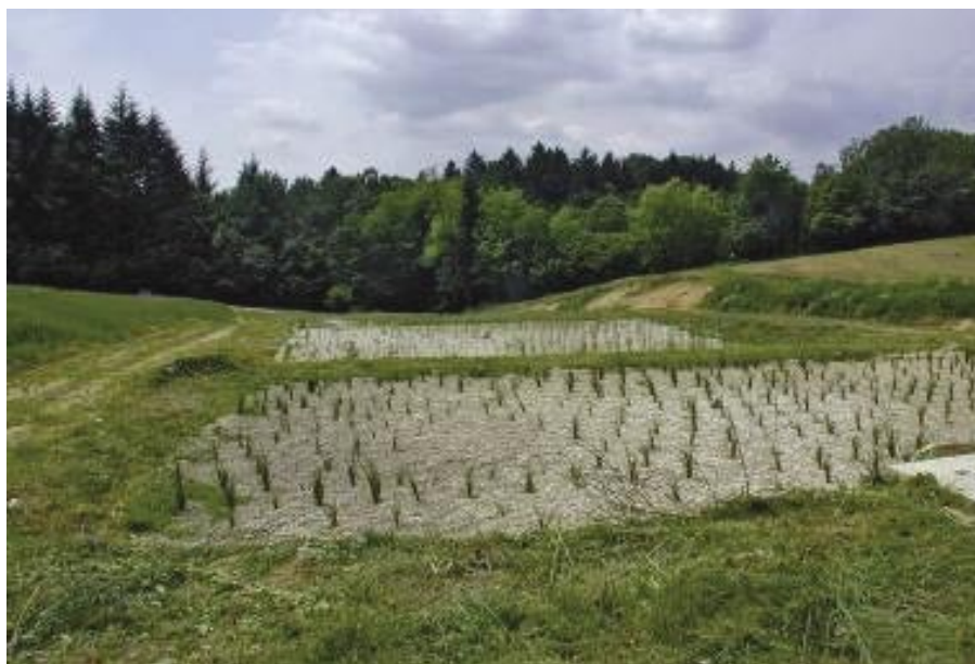
Slika 44: Rastlinska čistilna naprava za čiščenje komunalnih odpadnih voda in odpadnih voda iz kmetijske dejavnosti v naselju Sv. Tomaž (Vir: Arhiv LIMNOS)
