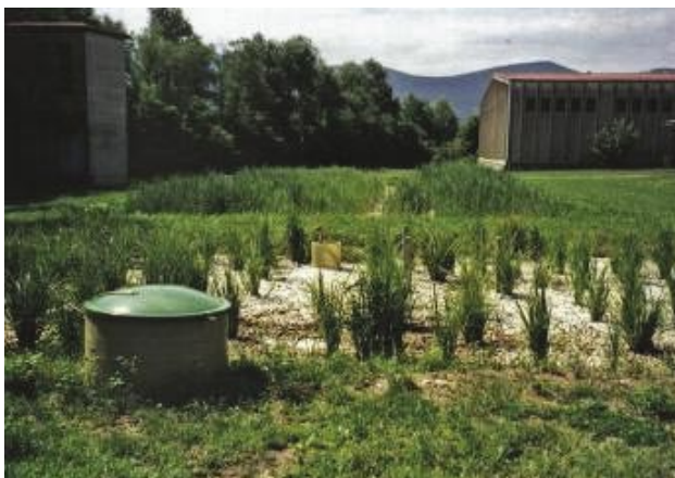
Slika 49: Rastlinska čistilna naprava za čiščenje odpadne vode iz tovarne Šampionka (Vir: Arhiv LIMNOS)
