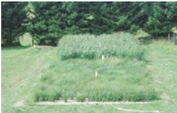
Slika 48: Rastlinska čistilna naprava za čiščenje odpadne vode iz živalske industrije (Vir: Arhiv LIMNOS)
