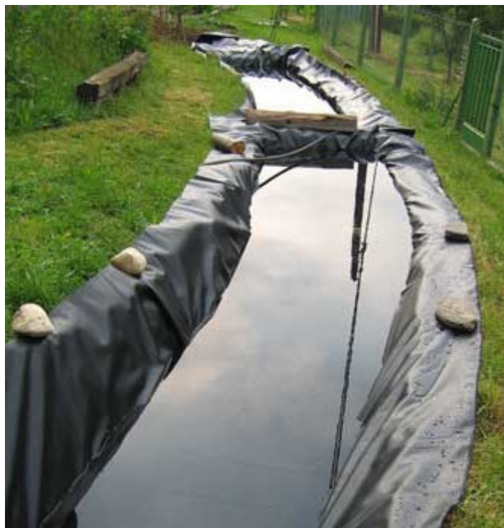
Slika 3: Polaganje nepropustne folije
