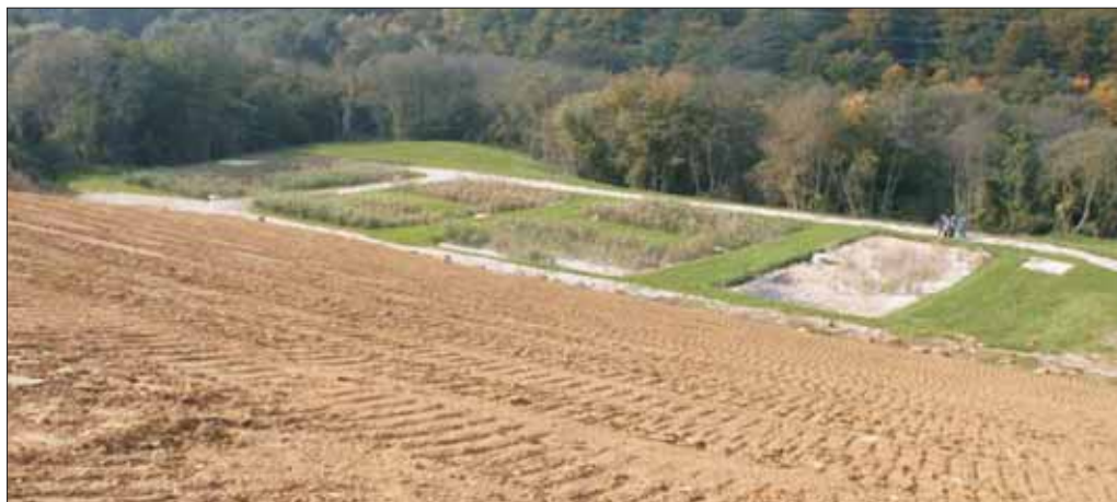
Slika 34: Sanacija deponije Dobrava in rastlinska čistilna naprava za čiščenje izcednih voda (Vir: Arhiv podjetja LIMNOS)
