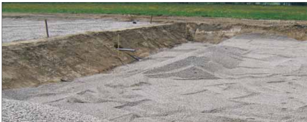
Slika 22: Spodnja plast v RČN je iz proda, skozenj teče voda in se čisti. Na sliki je gradnja RČN v Motovilcih. (foto A. Vovk Korže, 2006).
