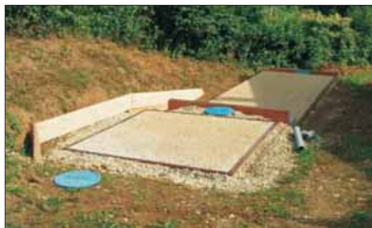
Slika 38: Rastlinska čistilna naprava za čiščenje pitne vode v Gerlincih pred zasadnjo (Vir: Arhiv LIMNOS)
