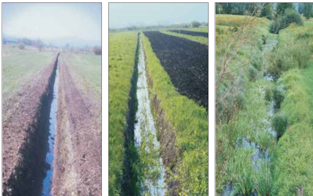
Slika 11: Na levi je goli melioracijski jarek in na desni ERM melioracijski jaerk. Razlika je v oblikovanosti brežine in zasjanosti z vegetacijo, ki opravlja pomembno čistilno funkcijo (Arhiv podjetja Limnos, 2005).
