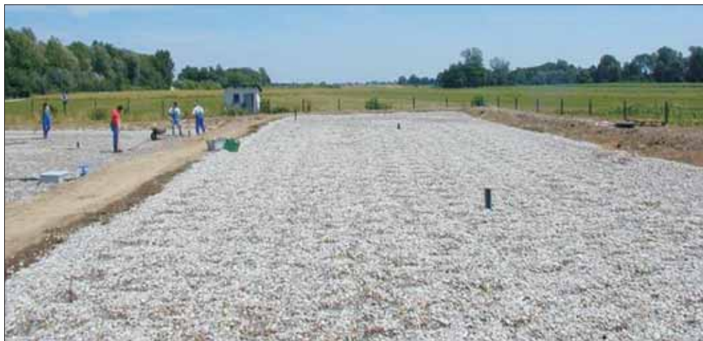
Slika 30: Izgradnja rastlinske čistilne naprave za čiščenje odpadne vode iz živilsko-predelovalne industrije v Središču ob Dravi (Vir: Arhiv LIMNOS)
