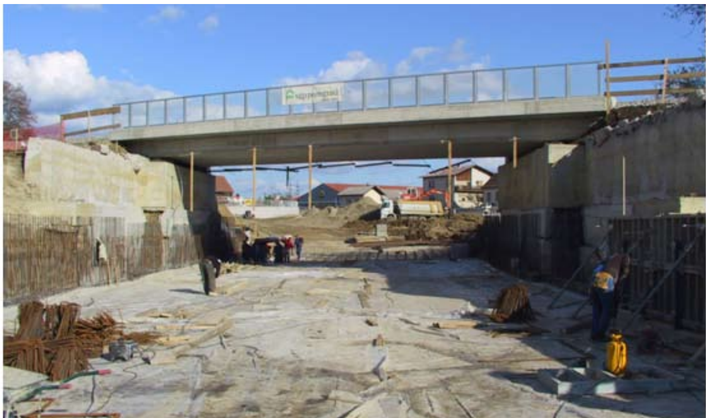
Stanje oktobra 2009 - gradnja kesona
