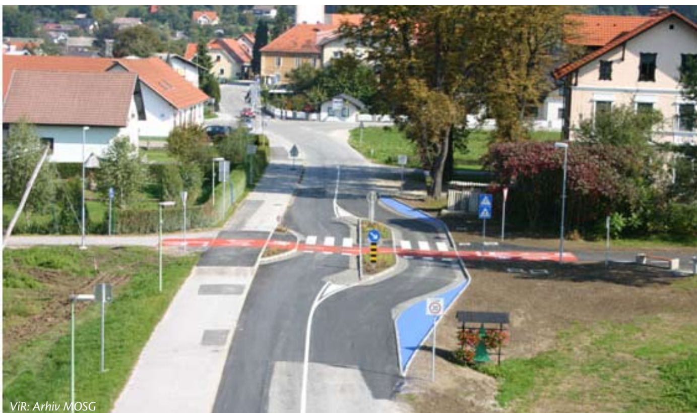
Fotografija: križanje lokalne ceste Šmartno in Kolesarske poti ter počivališča v Šmartnem, september 2008
