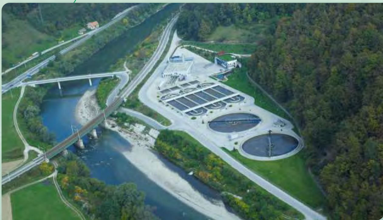
čistilna naprava Celje
