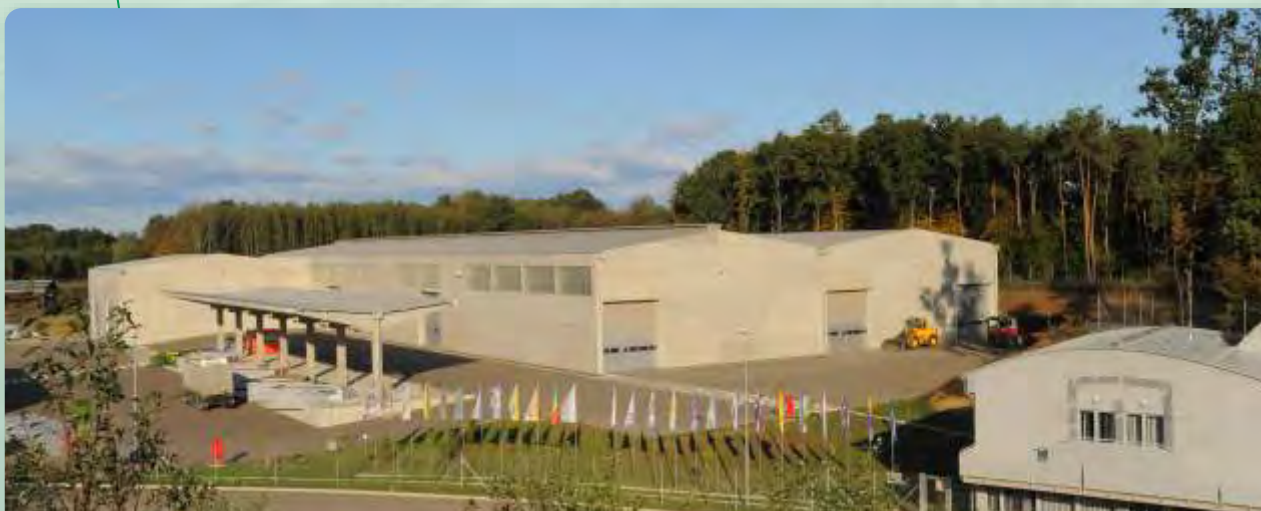
hala za mehansko obdelavo odpadkov
