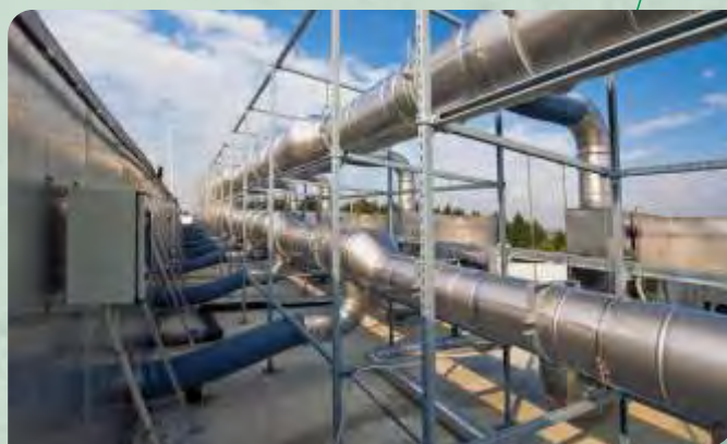
prezračevalni sistem v kompostarni
