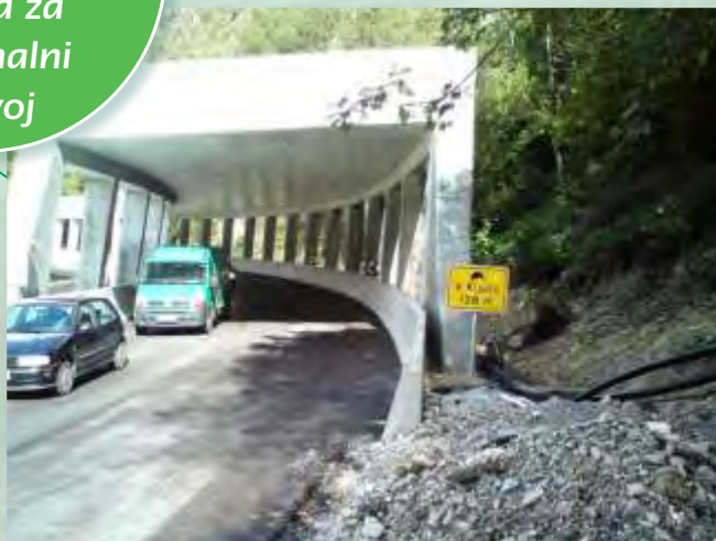
izvedena gradnja in rekonstrukcija
